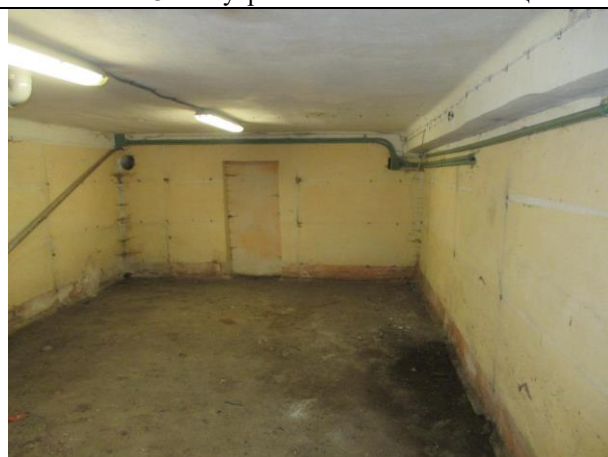
Фото № 30 – Внутреннее состояние помещения
