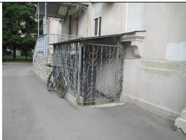
Фото № 5 – Приямок, где расположен общий вход в подвал
