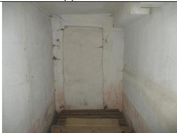
Фото № 21 – Внутреннее состояние помещения
