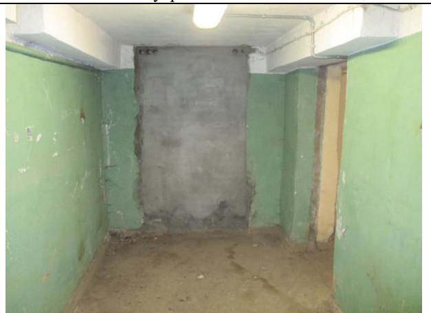
Фото № 22 – Внутреннее состояние помещения
