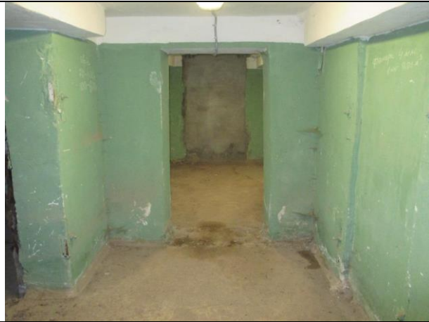
Фото № 15 – Внутреннее состояние помещения
