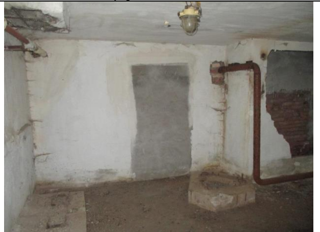
Фото № 18 – Внутреннее состояние помещения
