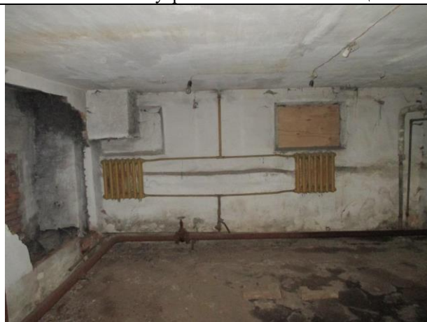
Фото № 19 – Внутреннее состояние помещения
