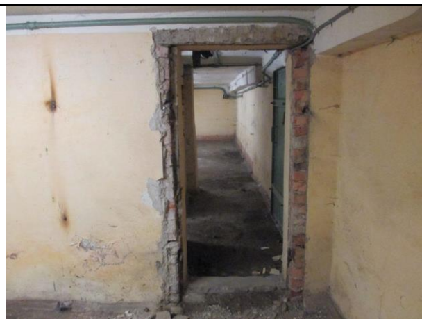
Фото № 24 – Внутреннее состояние помещения
