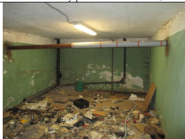
Фото № 14 – Внутреннее состояние помещения
