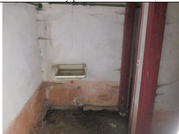
Фото № 26 – Внутреннее состояние помещения
