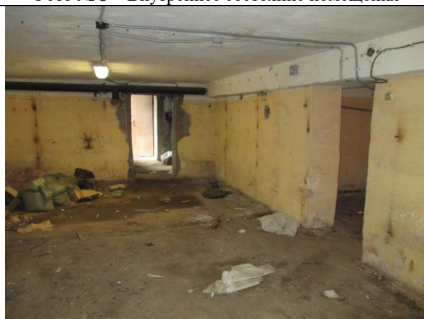
Фото № 11 – Внутреннее состояние помещения
