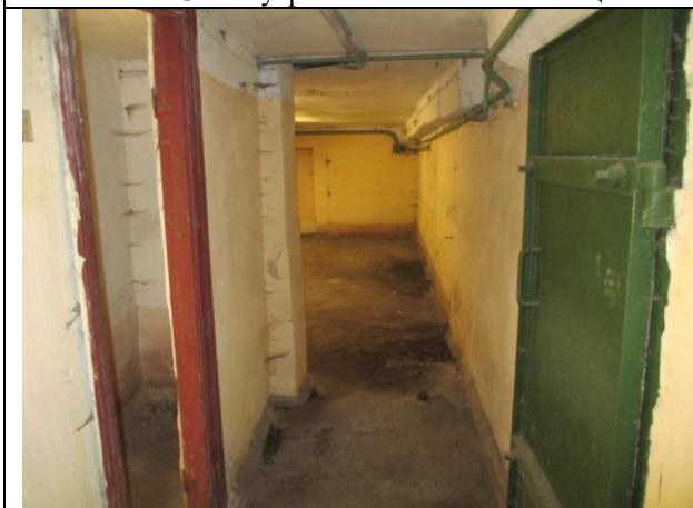
Фото № 25 – Внутреннее состояние помещения
