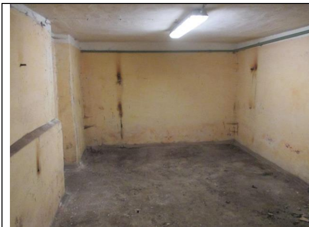
Фото № 23 – Внутреннее состояние помещения
