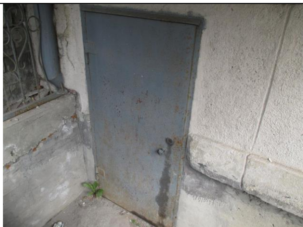
Фото № 6 – Вход в подвал
