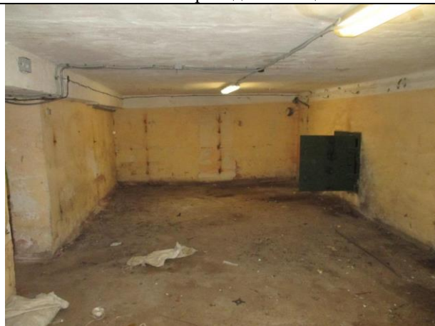
Фото № 9 – Внутреннее состояние помещения
