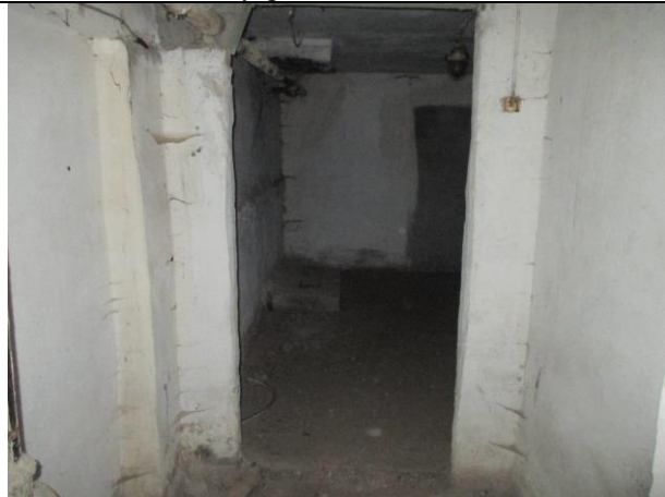
Фото № 17 – Внутреннее состояние помещения
