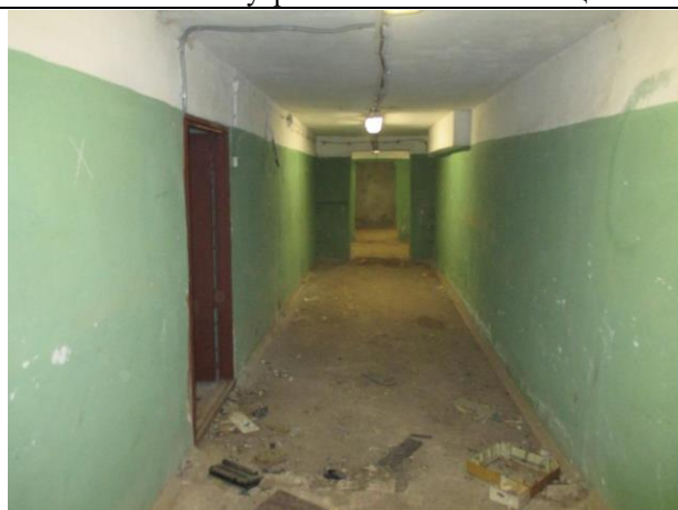
Фото № 13 – Внутреннее состояние помещения
